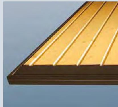
El revestimiento de madera situado dentro del marco, con zócalo visible, como protección contra las salpicaduras de agua.
