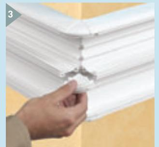
3 Encaje la tapa flexible sobre las muescas de la canal y del accesorio del ángulo
