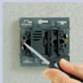
Fijación en caja de empotrar, después de la conexión del aparato
