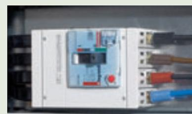
Ejemplo de utilización de manguitos en un DPX 250 cableado
