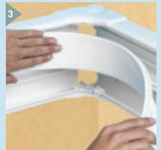
3 Encaje la tapa flexible sobre las muescas de la canal y del accesorio del ángulo
