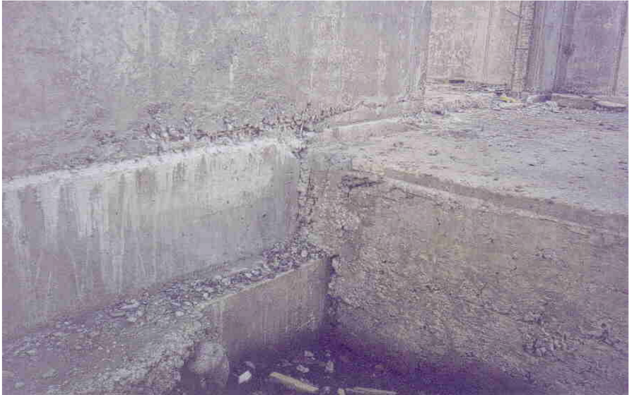
Figura 43. Segregación en la base del muro (ENACO Los Domínicos)
