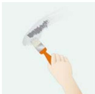
2. Aplique una imprimación para pintura o una disolución selladora para preparar la superficie.
