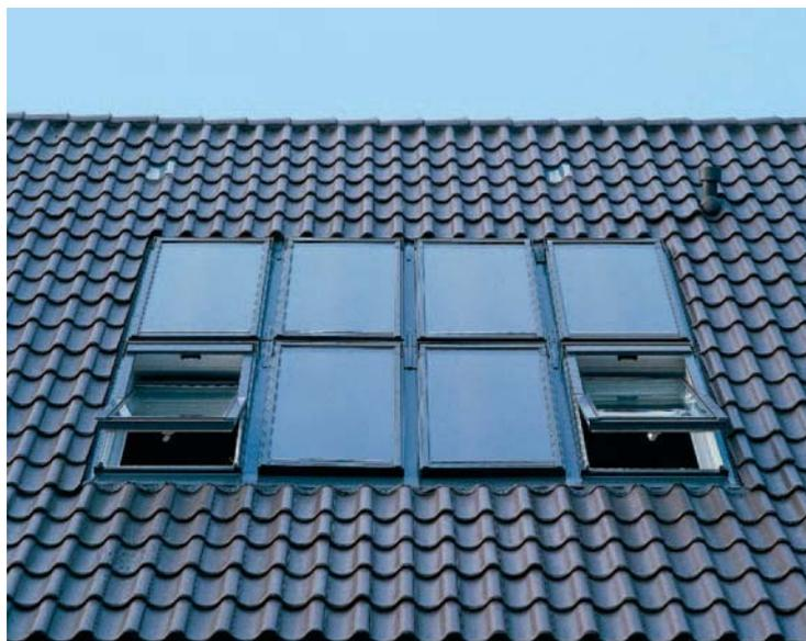
El sistema de cercos de estanqueidad VELUX permite una fácil instalación de los captadores solares, ya sean contiguos o superpuestos, a la vez que facilita la combinación de captadores solares y ventanas para tejado VELUX. Los cercos de estanqueidad están disponibles en aluminio, cobre o zinc-titanio.
