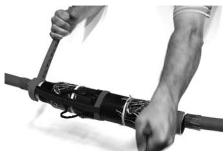
Por medio de las dos palancas suministradas rompemos el tubo de soporte realizando un movimiento de torsión sobre el empalme. Posteriormente se cortan las gomas que mantienen sujeta la pantalla y mediante los anillos metálicos de presión constante suministrados realizaremos la operación de conexionado de las pantallas. Sobre los cables previamente preparados aplicamos las placas de sellado de goma vulcanizable.
