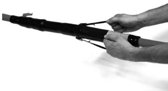
Finalizaremos el montaje del empalme desdoblado las cubiertas, estirando de las cintas de goma incorporadas en el propio empalme.
