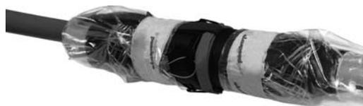
Se realizan cortes para la extracción de la cubierta exterior dejando una distancia para la conexión de la pantalla de hilos de cable y se extrae la capa semiconductora (con especial cuidado de no afectar al aislamiento) para posteriormente hacer la conexión de los conductores. Una vez hecha la unión de los conductores, centramos el empalme sobre el manguito.
